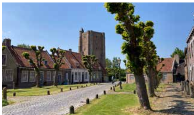
Figuur 16: Bestrating met ballastkeien op het marktplein van Sint Anna Ter Muiden
